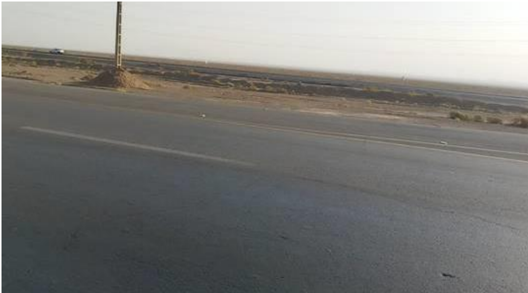
شکل ۱- اجرای ۳,۵ کیلومتر آسفالت در محور نایین به اردکان در سال ۱۳۹۶
