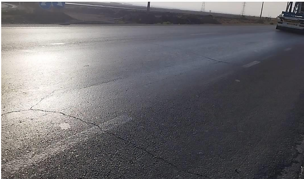
شکل ۲- نمایی از آسفالت پودرلاستیکی پس از ۷ سال از اجرای آن در روسازی با PCI پایین
